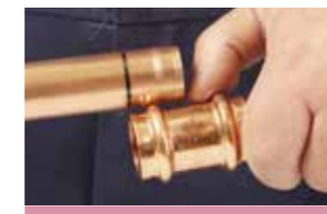
7b. Verifica della profondità di inserimento
