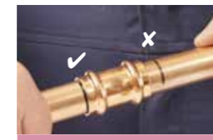
8. Inserire il tubo nel raccordo, assicurandosi che sia completamente in battuta prima di procedere alla pressatura
