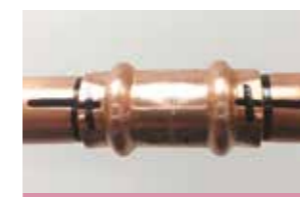
11. Identificazione della giunzione completata
